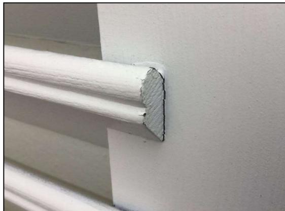
Abb. 4.3: Rissbildung in der Fuge und an den zu wenig abgerundeten Kanten
