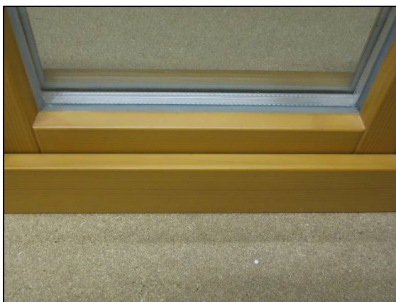
Obr. 4.3: Hliníkové profily bez ochrany proti povětrnosti
