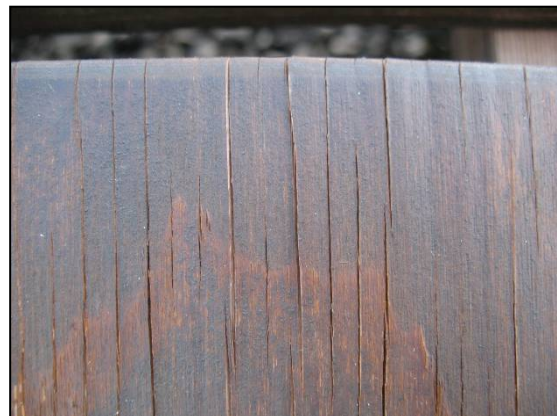
Obr. 2.3: Vznik trhlin
