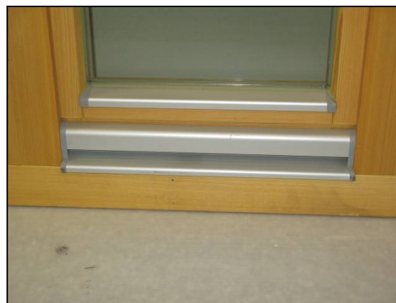
Obr. 4.4: Hliníkové profily s ochranou proti povětrnosti
